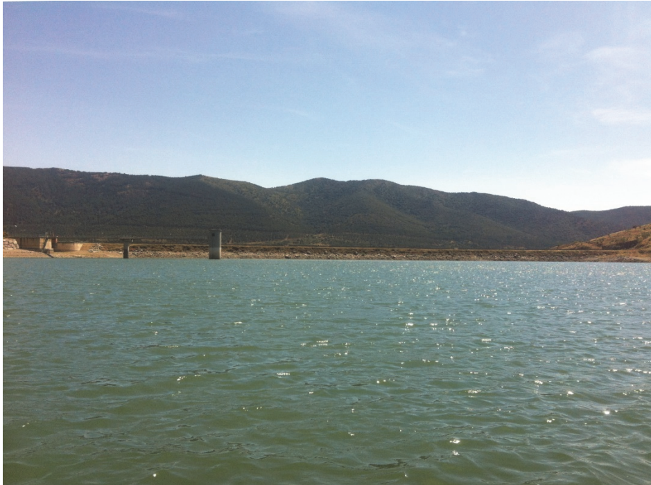
Figura 7. Vista de la presa del embalse.
