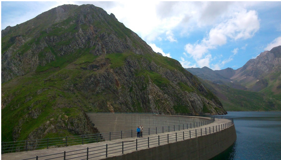
Figura 7. Vista de la presa del embalse
