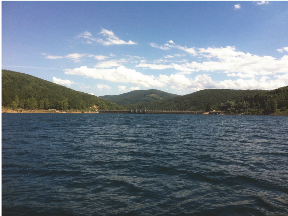
Figura 7. Vista de la presa del embalse
