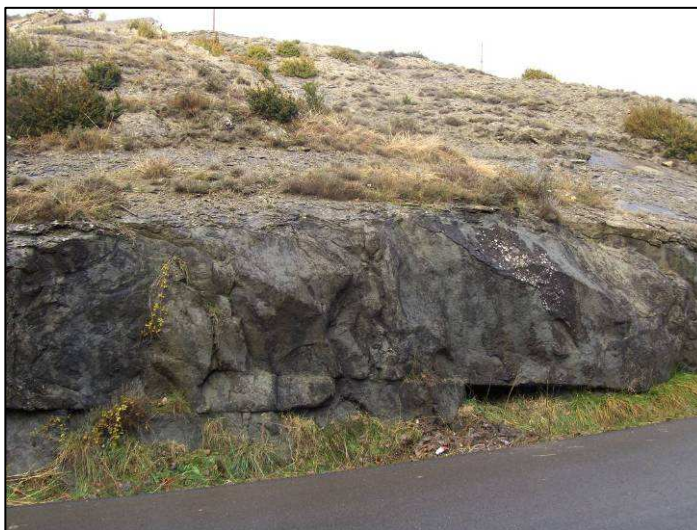
Figura 9. Fotografía de las Areniscas de Sabiñánigo en la zona trasera de la cerrada del embalse.
