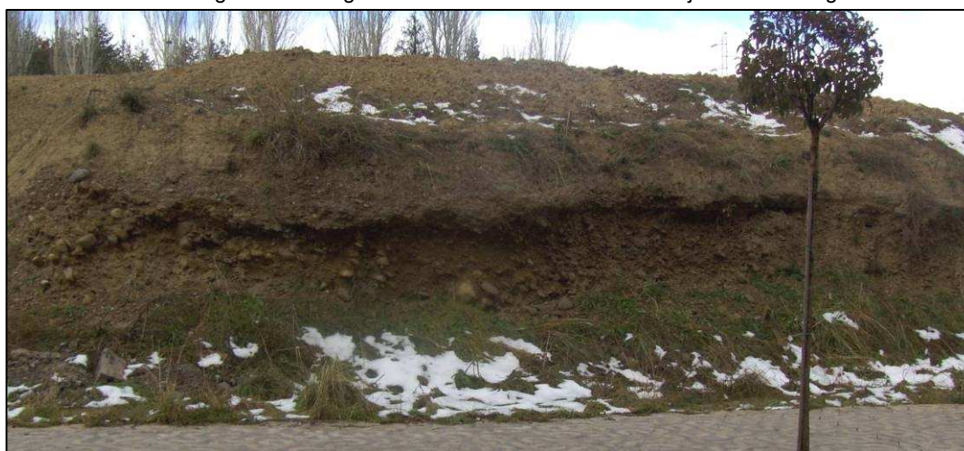
Figura 11: Fotografía de un corte en una terraza baja en Sabiñánigo.
