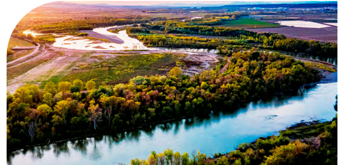
Retranqueo de mota en el río Ebro. “El Estajao”, Alfaro (La Rioja)
