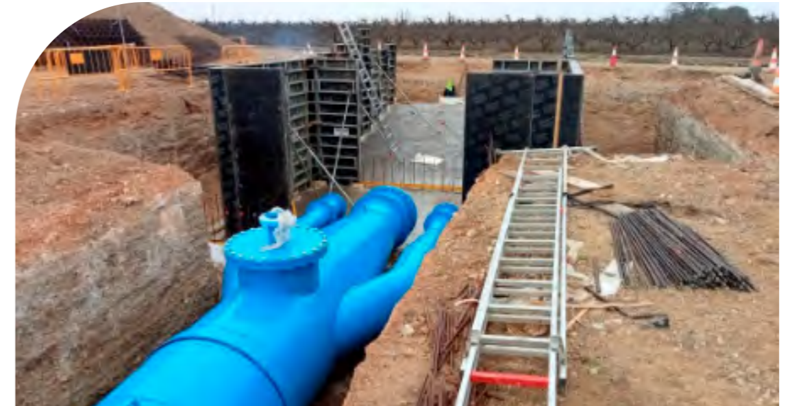
Arqueta vertido pieza pantalón Acequia La Mola
