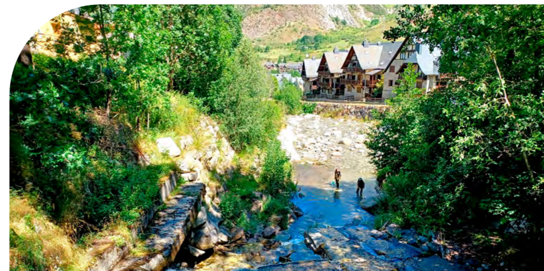
Pesca eléctrica, previo a las actuaciones en el río Valarties (Lleida)
