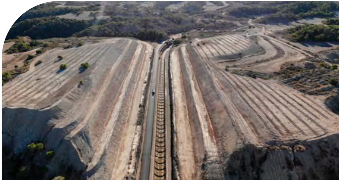
Vista aérea trinchera Alcubierre
