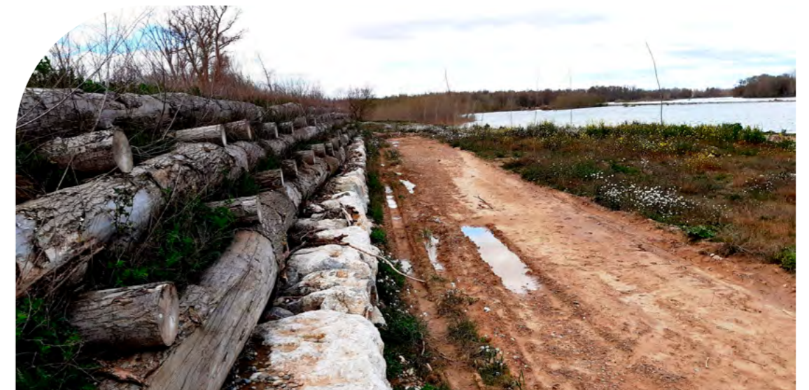
Muro Krainer en mota del río Ebro en “El Estajao” (La Rioja)
