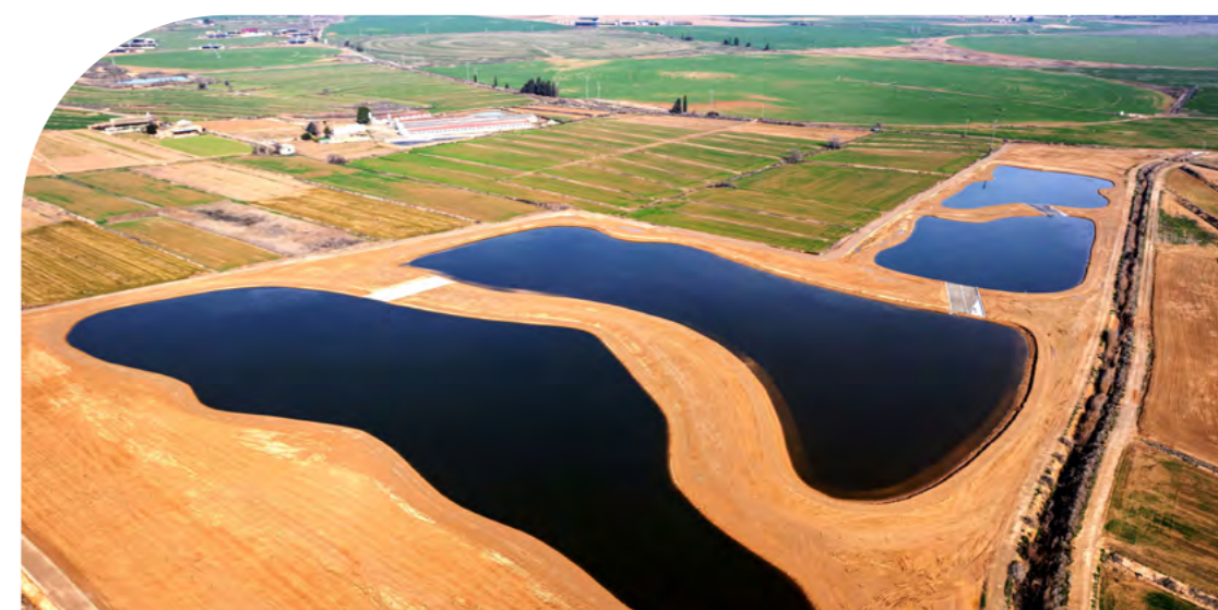
Balsas de desnitrificación en la finca de la Melusa (Huesca)
