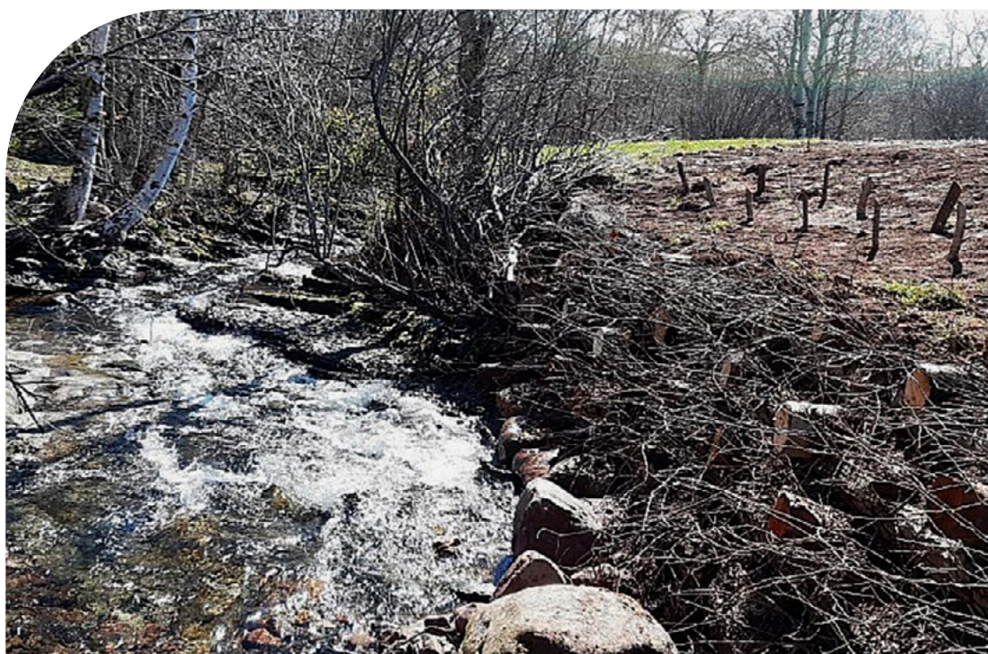
Muro Krainer (bioingeniería) en la ribera del río Soto (Cantabria)
