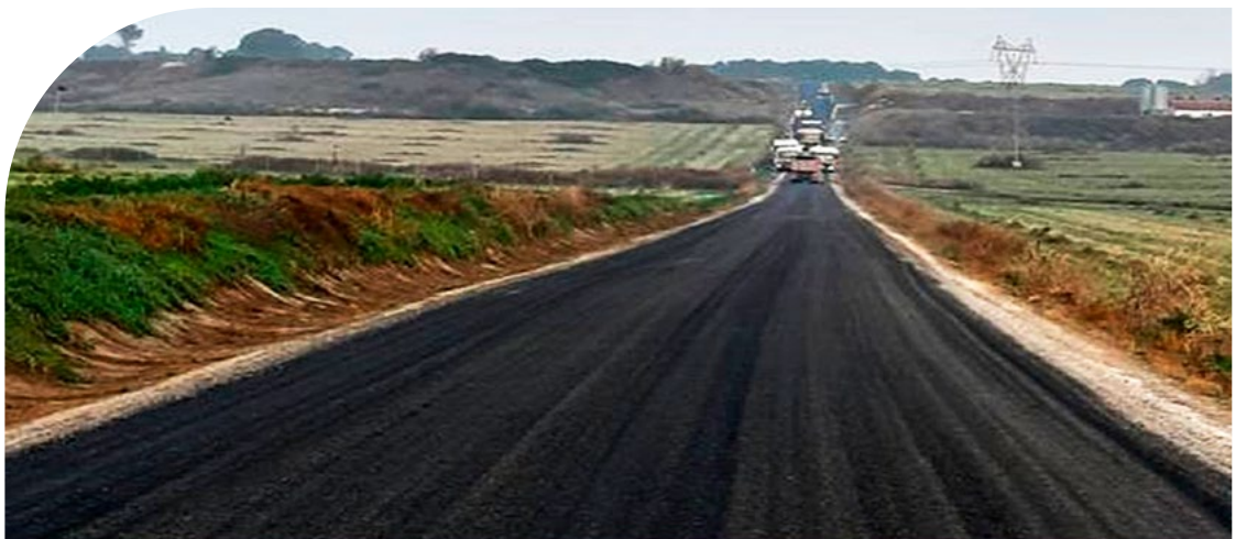
Carreteras de la zona regable del canal de monegros
