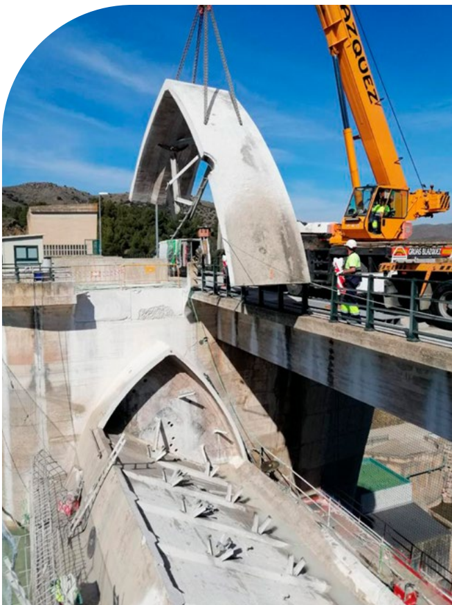
Cambio de compuerta de aliviadero embalse de La Tranquera (Zaragoza)
