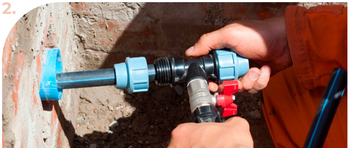
Actuaciones para la mejora de abastecimiento a Fornillos, Huesca
