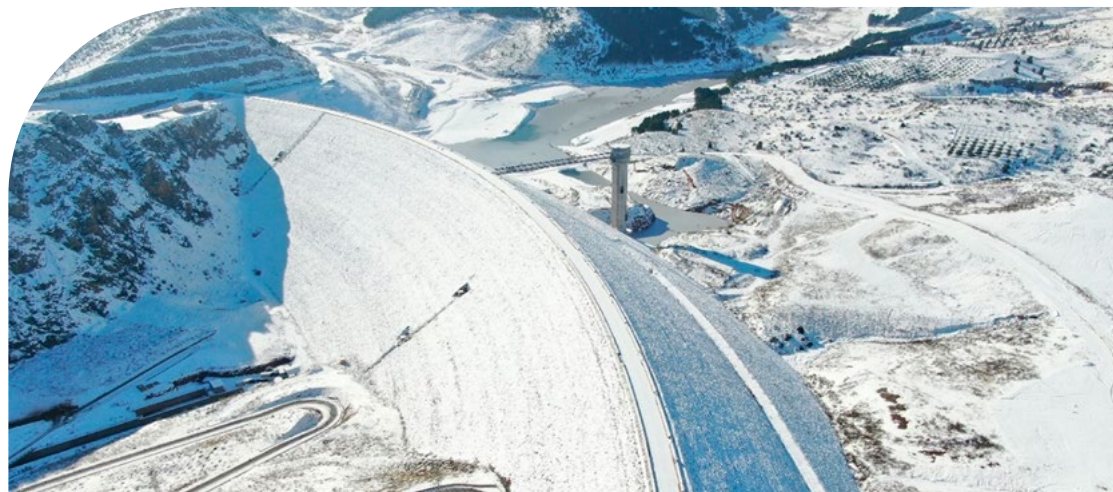
Presa de Mularroya
