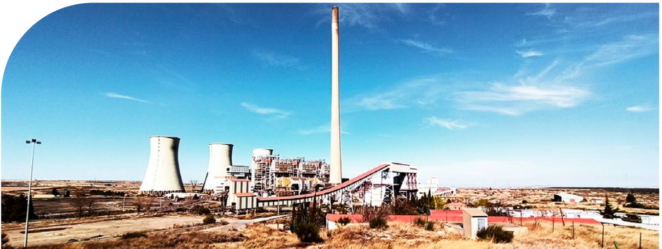
Central Térmica de Andorra
