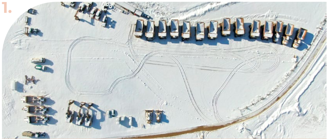
Obras del embalse de Almudévar, Huesca
