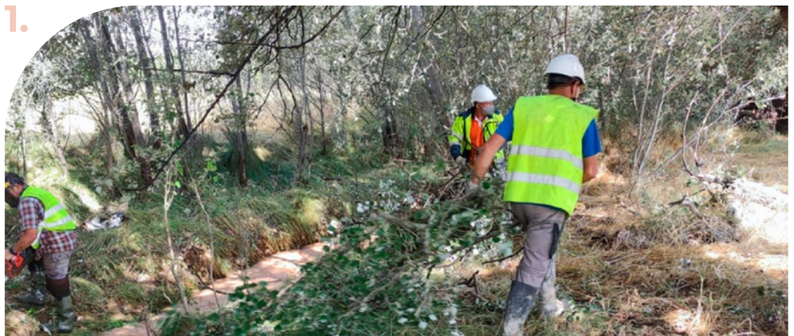
Mantenimiento de cauces
