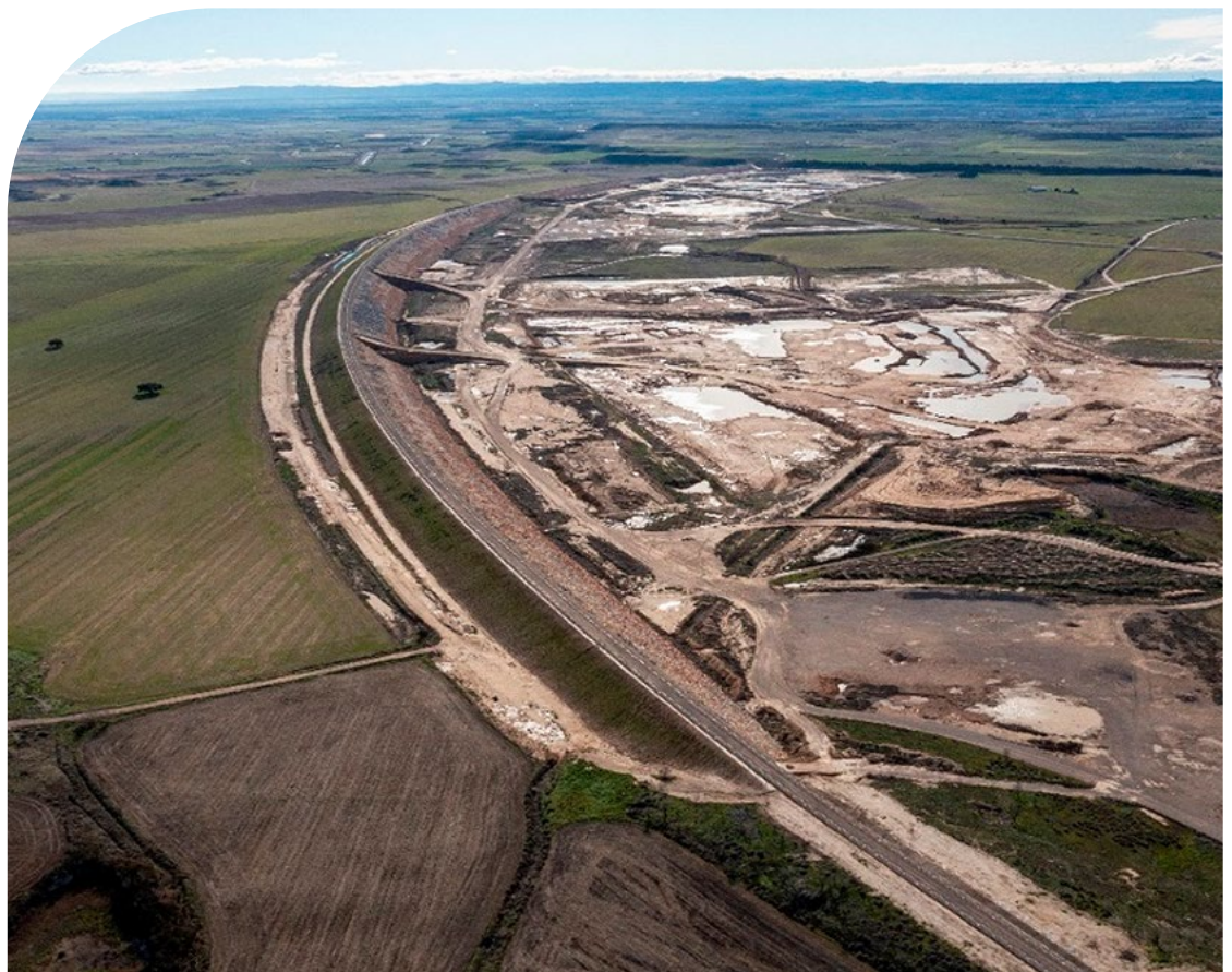
Estado actual dique este
