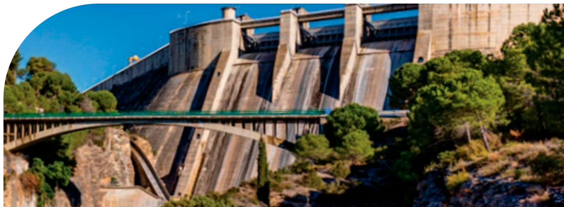
Presa de el Grado
