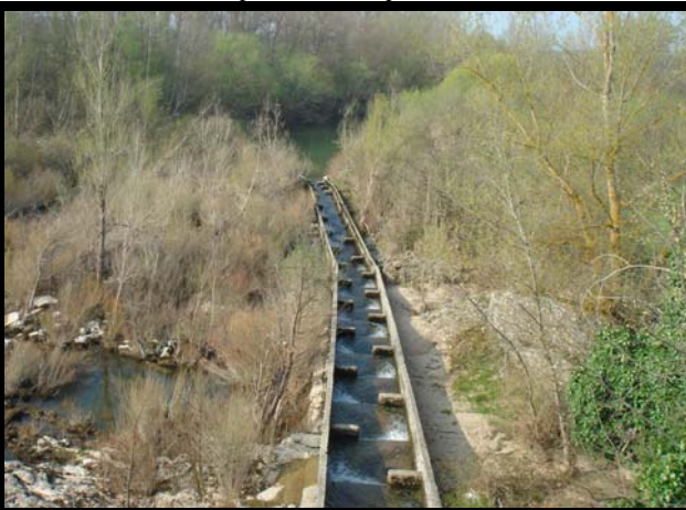
Escala de peces en el estribo derecho de la presa
