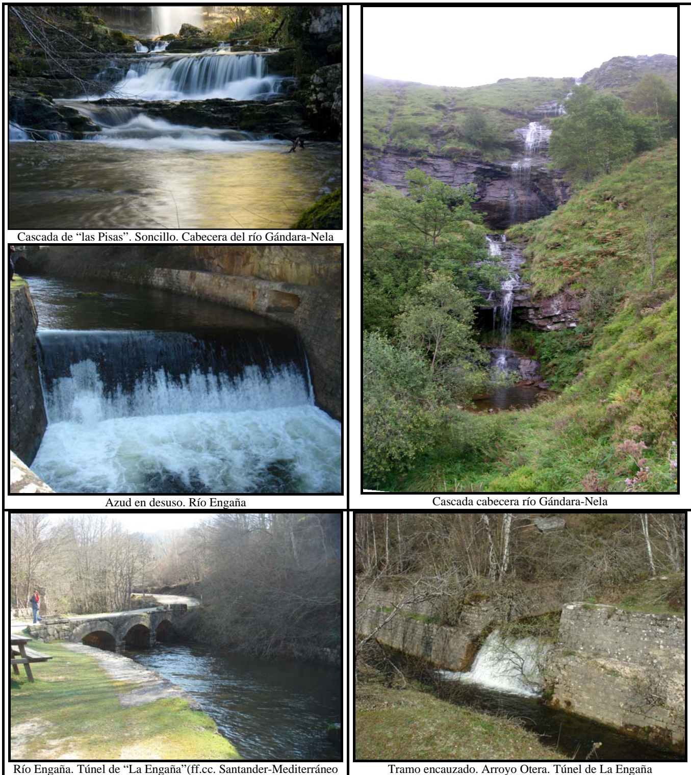
Figura 65: Fotos representativas de las características y problemas de la masa 474. (Fotografías de archivo, y de abril de 2.007)
