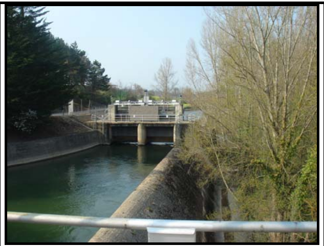
Toma del Canal alimentador de la C.H. Quintana, en el embalse de Cillaperlata
