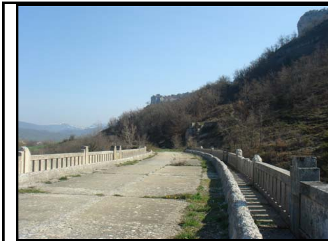
Viaducto Santelices ff.cc. Santander-Mediterráneo S/Río Nela
