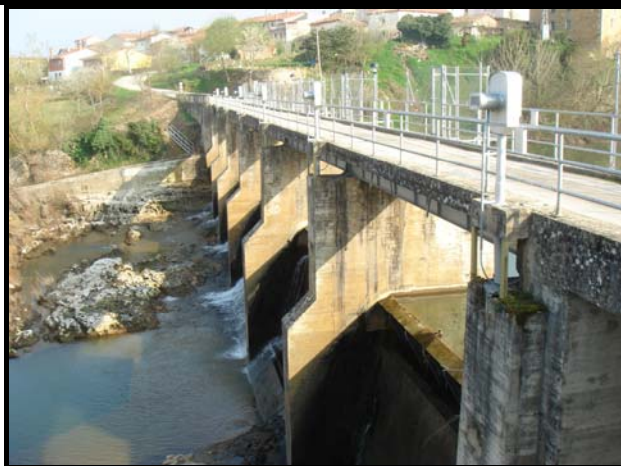
Presa del embalse de Cillaperlata Coronación y aliviadero de la presa de Cillaperlata
