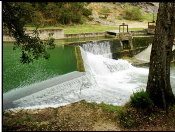
Río Omecillo. CH Barrio del Puente
