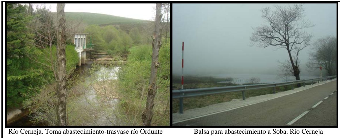
Figura 71 (continuación): Fotos representativas de las características y problemas de la masa de agua 477 (Fotografías tomadas en mayo de 2.007).
