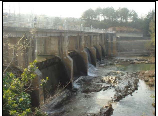
Coronación y aliviadero de la presa de Cillaperlata
