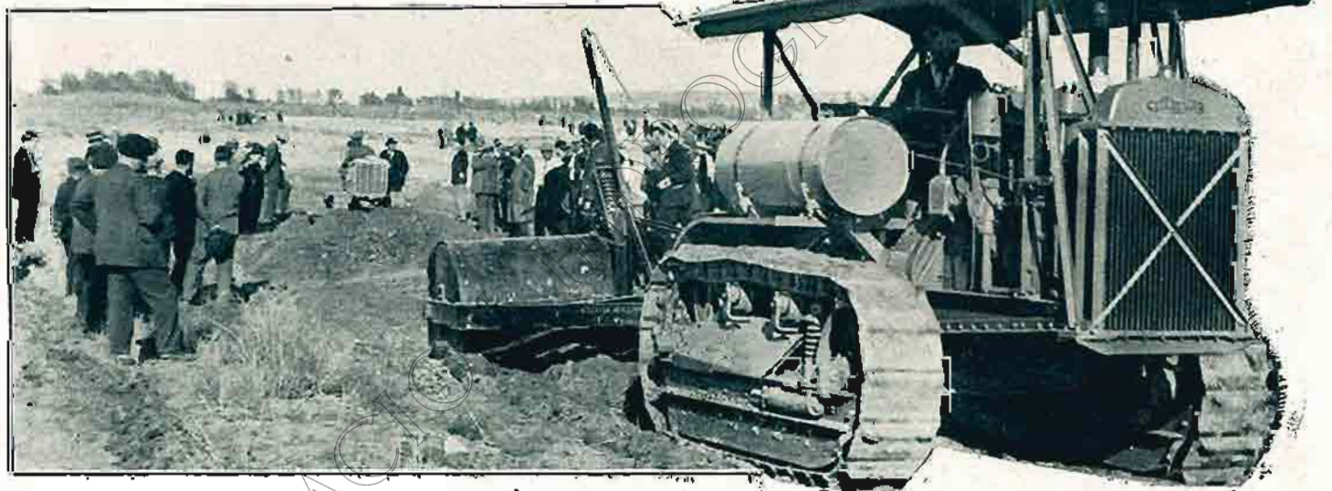
EL EQUIPO DE NIVELACIÓN «CATERPILLAR» 60 HP. Y ARROBADERA «KILLEFER», REALIZANDO PRUEBAS
