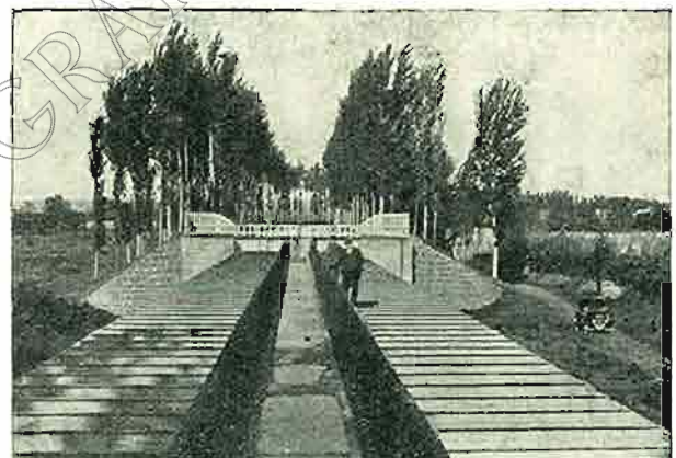
Aqueducto Sió, en Agramunt (Lérida), protegido con INERTOL
