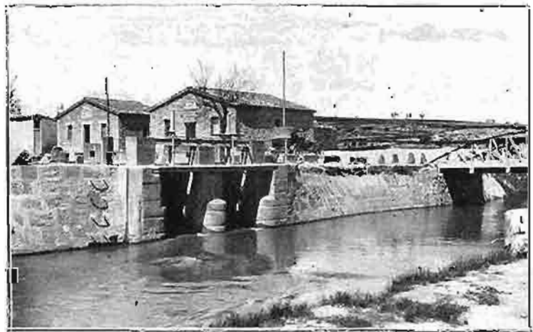
CANAL DE URGEL: CASIELA Y YOMA DE LA PRIMERA ACEQUIA PRINCIPAL
