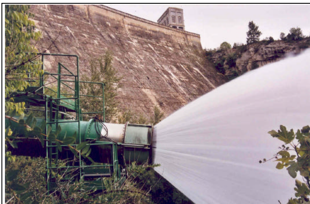
Foto 3. Vertido a través de válvula Howell en la presa de Talarn.
