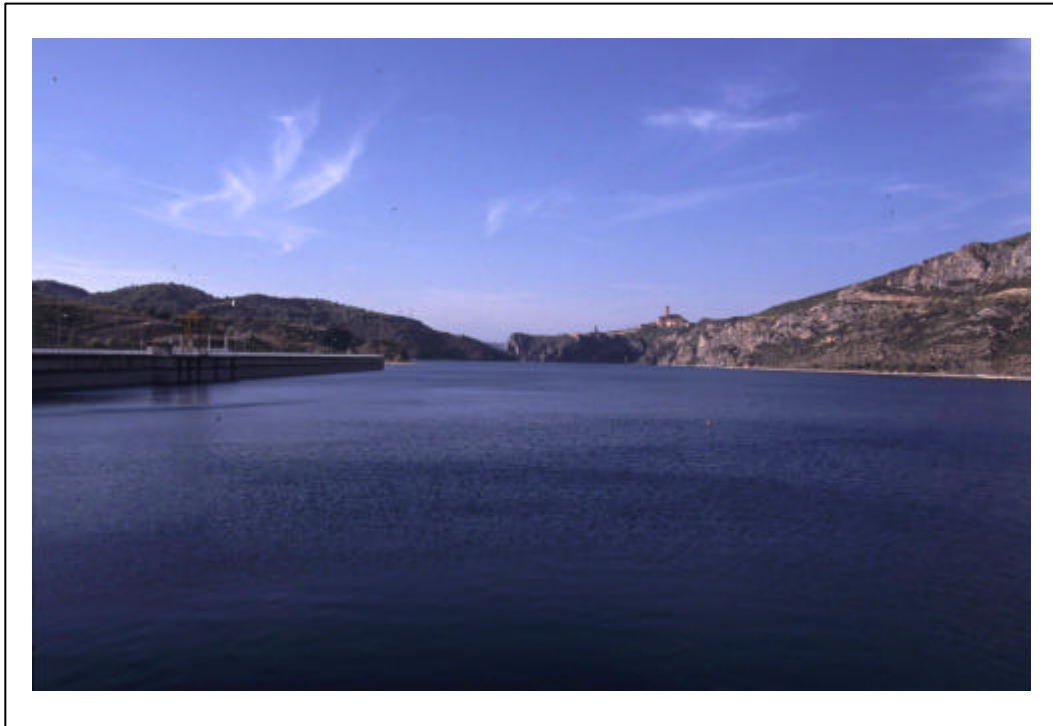
Foto 1. Vista del embalse en septiembre de 2001.
