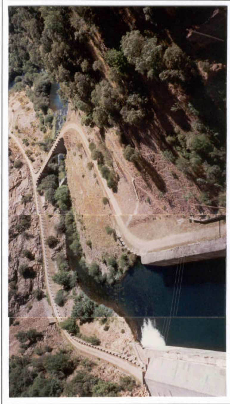
Río Najerilla aguas abajo de la presa de Mansilla.
